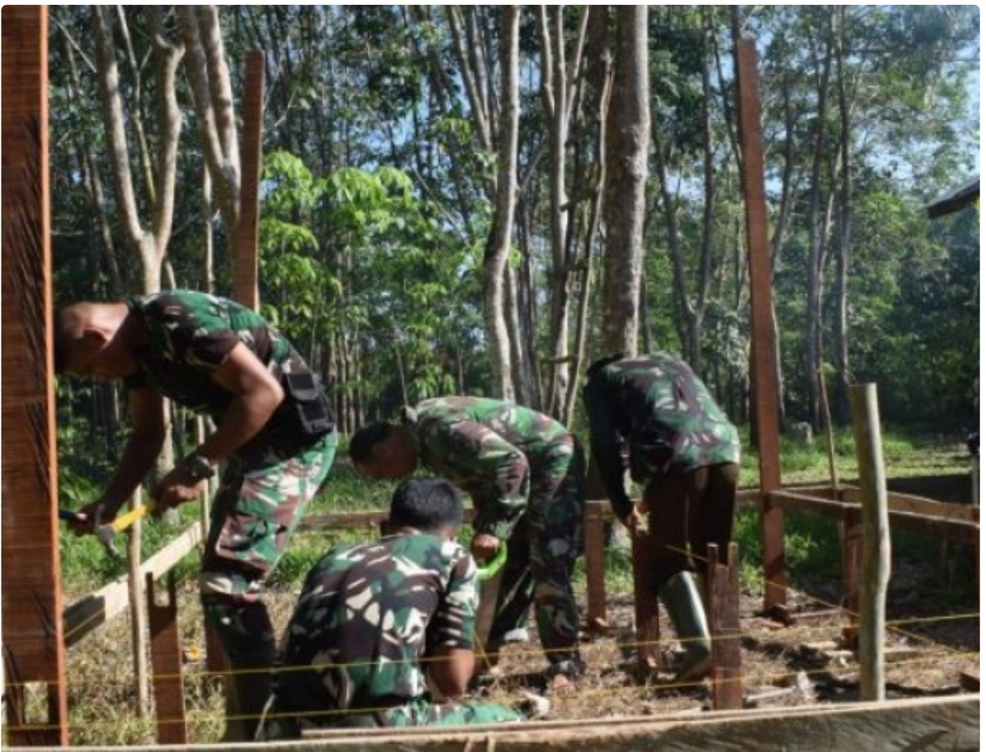
Satgas TMMMD Ke-113 Kodim 1005/Barito Kuala Kebut Pembangunan Pos Kamling
