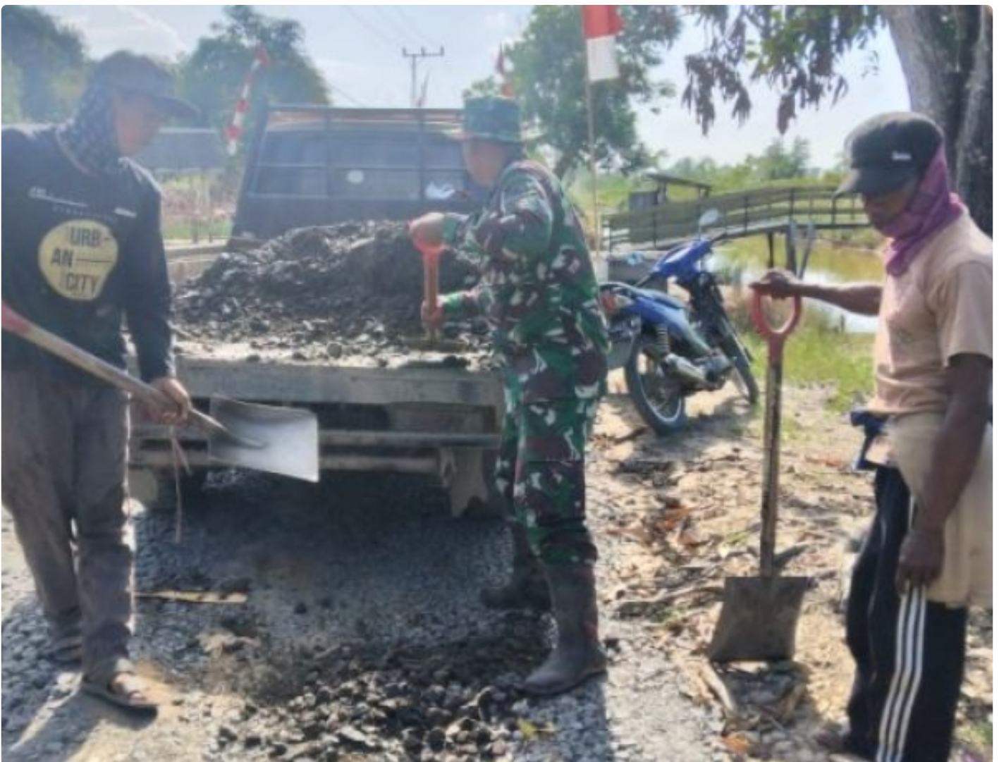
Satgas TMMD Ke-113 Kodim 1005/Barito Kuala Kebut Pengerjaan SasaranJalan
